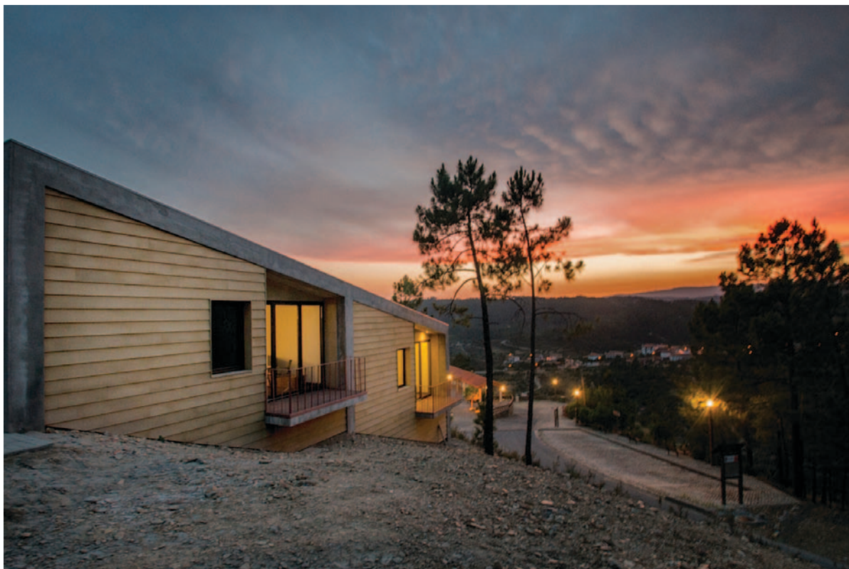
Ventilated Facades – Viroclin | MB-Arquitectos | Beira Baixa, Portugal
